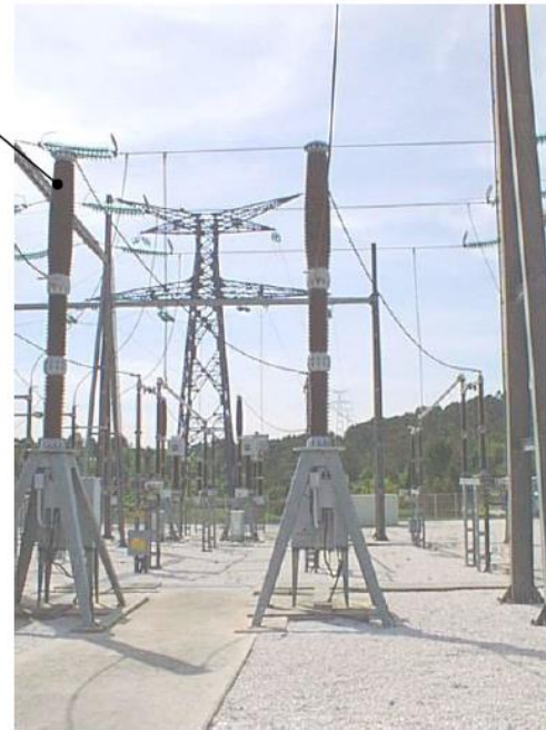
---- disjoncteur 63 kV au SF6 ----
