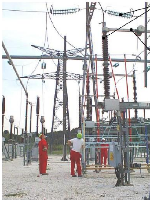
---- Sectionneur 63 kV ----
